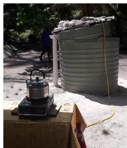
Un bio-digester produit du méthane à partir de déchets de porcherie à Funafuti, Tuvalu (CPS, 2022)
